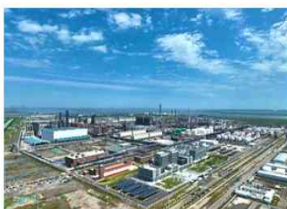
中石化南港120万吨乙烯项目投产
