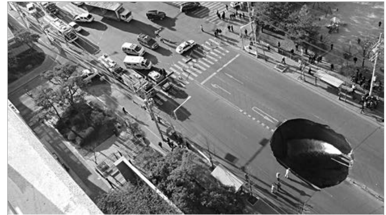
출처: “불안해서 살겠나-위험천만 인천지하철 공사장” (jtbc 12/02/19).
